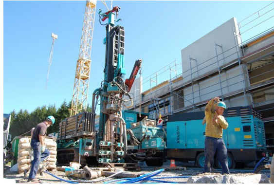
Abbildung 6-15: Bohrung für Erdsonden zur Nutzung oberflächennaher Geothermie mittels Wärmepumpen im Gebäudebereich Quelle: www.waermepumpen.info
