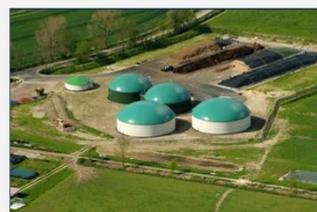
In Biogasanlagen wird aus sogenannter Biomasse (Pflanzeneresten, Holz, organische Abfälle) hergestelltes Biogas verbrannt. Dabei entstehen in Kraft-Wärme-Kopplung (KWK) sowohl Strom als auch Wärme. Häufig wird die Wärme in einem Nahwärmenetz zur Beheizung von Gebäuden genutzt.
