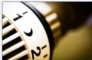
Beim hydraulischen Abgleich werden die Heizungsventile so eingestellt, dass alle Heizungskörper mit der genau richtigen Durchflussmenge versorgt werden. Dadurch werden alle Heizungskörper, egal wie weit sie von der Heizzentrale entfernt sind, wieder gleichmäßig warm und ggf. kann zusätzlich die Leistung der Heizpumpe reduziert werden.
