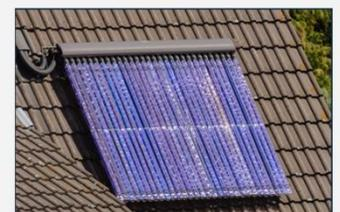
Ähnlich der Photovoltaik wandeln auch Solarthermieanlagen das Licht in Energie (Warmwasser) um. Solarthermie wird im privaten Bereich v.a. zur Gebäudeheizung genutzt. Verbunden mit einer guten Wärmedämmung vermindert sich der Bedarf an zusätzlicher Heizenergie stark. Bei idealer Planung kann eine aktive Heizungsanlage nicht mehr erforderlich sein.
